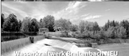
Wasserkraftwerk Breitenbach NEU
